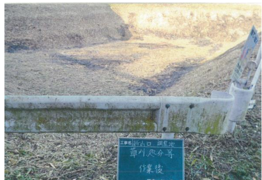
調整池の草刈・伐採（作業後）
