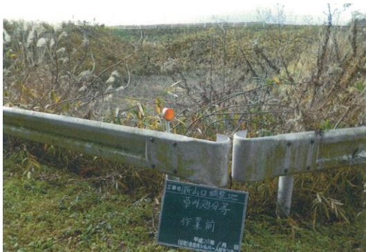
調整池の草刈・伐採（作業前）
