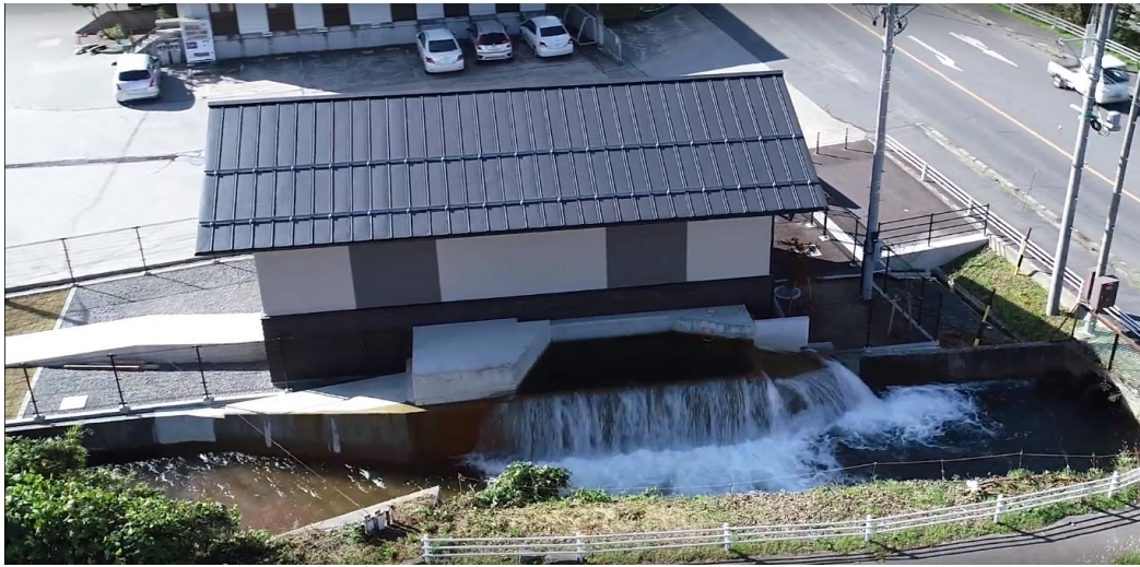
【小布施松川小水力発電所 水車外観（上）、建屋外観（下）】
