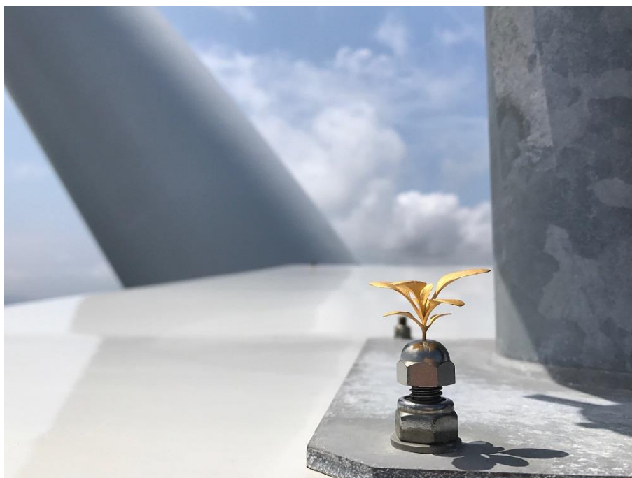
唐津市湊風力発電所に設置された『雑草』
