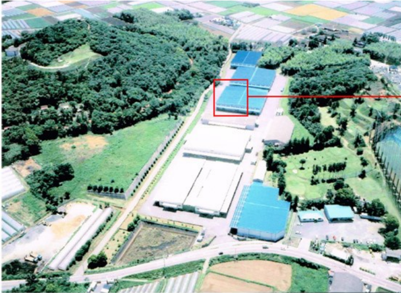
↑熊本製粉株式会社西合志倉庫
