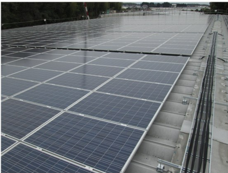
↑屋根上に設置したソーラーパネル
