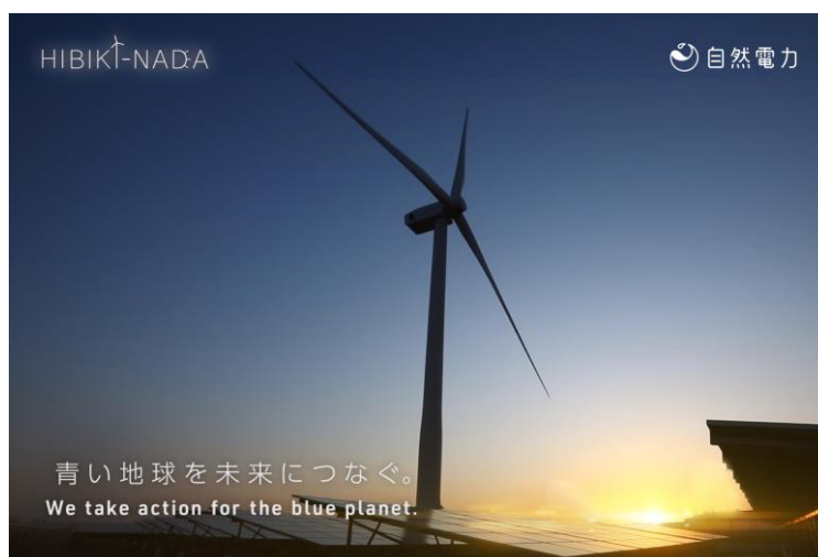
「北九州響灘風力発電所・太陽光発電所」外観（動画： https://youtu.be/YJdg365cDBw ）
