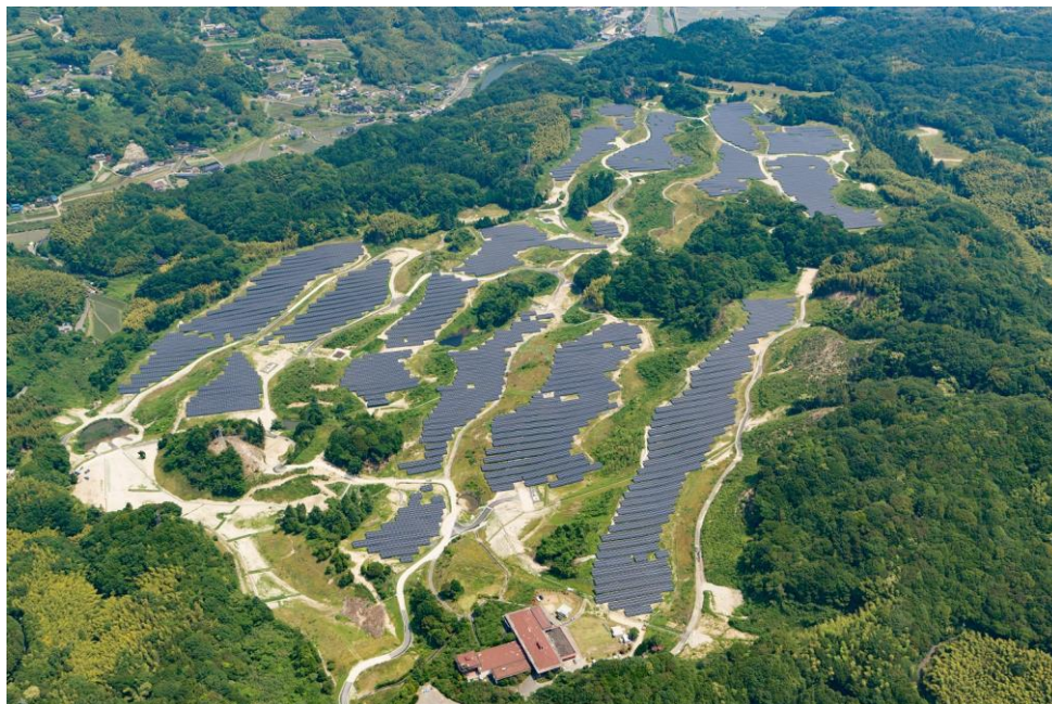
発電所の全景
