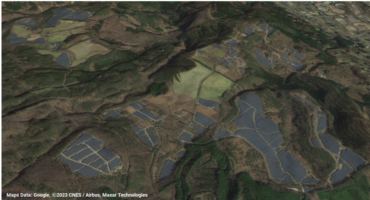
本発電所全景
