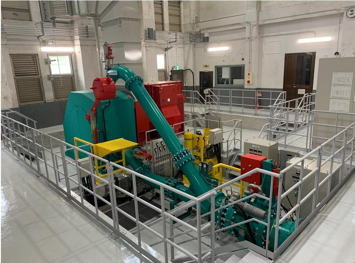
写真：黒田水力発電所に納入したペルトン水車・同期発電機
