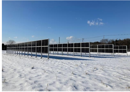
写真右：垂直式太陽光発電設備イメージ（2023年12月、自然電力が酪農学園大学敷地内に設置したもの）
